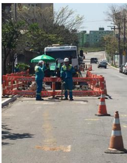
Fotos: Obras Rede Fonte: SSMQ
